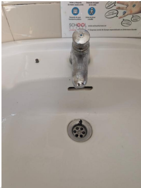
Imatges 10 i 11: Aixetes amb temporitzadors i cisternes de descàrrega única
