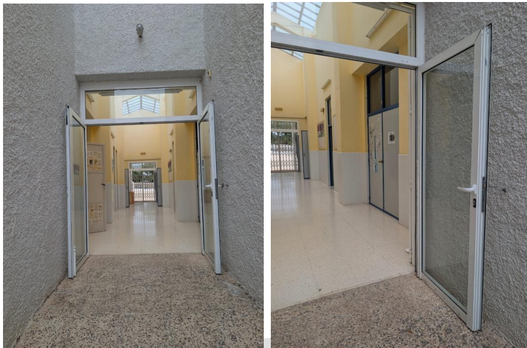
Imatges 7 i 8: Portes d'entrada a un dels edificis
